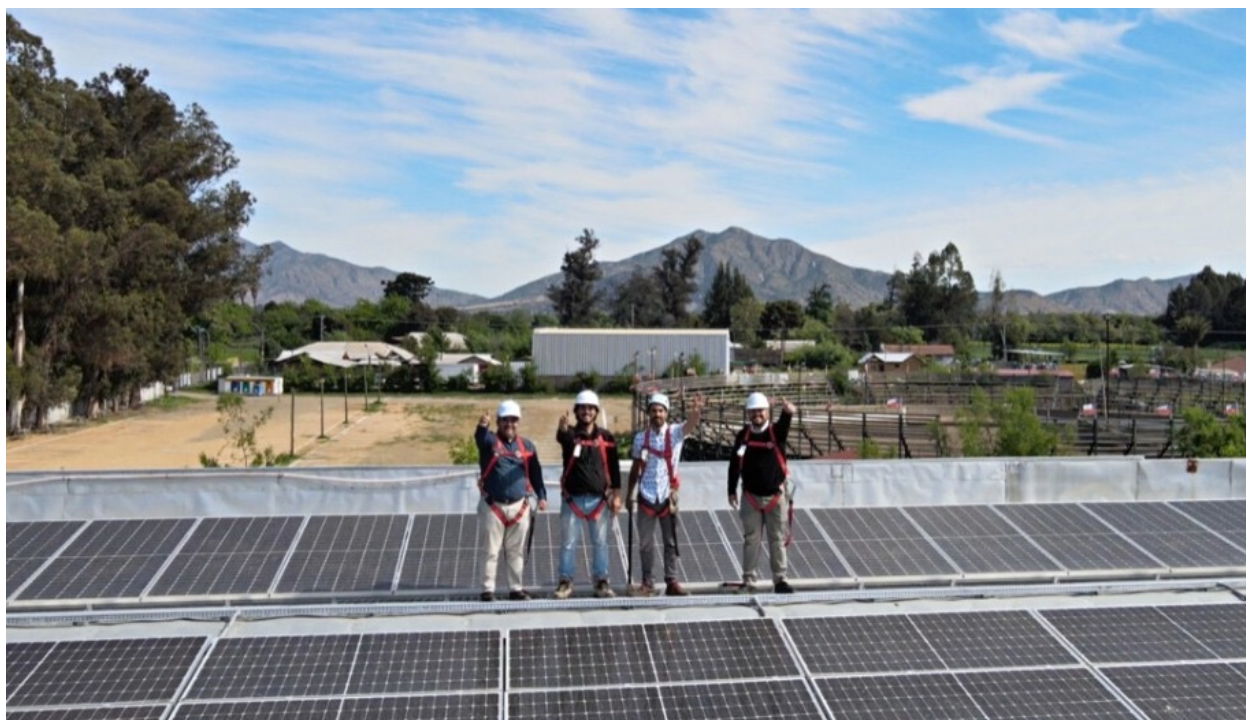
Inauguración planta fotovoltaica proyecto nuevo calor
